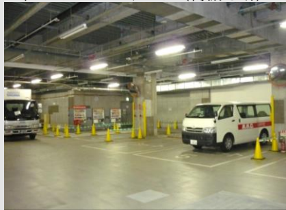
◆B1Fサービスヤード（荷捌き場）
